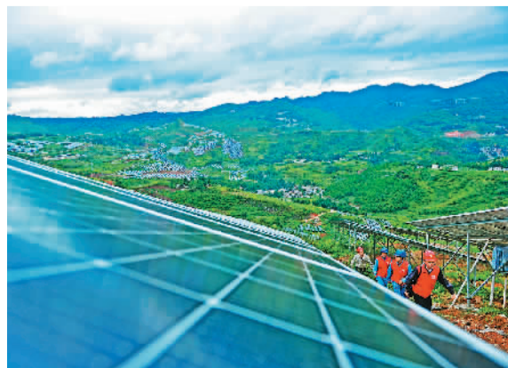
近年来，南方电网六盘水供电局积极推动清洁能源发电上网，水电和新能源装机容量占发电装机容量的49.7%。图为该局组织党员服务队深入光伏电站协助检查设备。 张亮 刘菲菲 摄影报道
