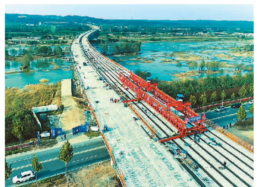
10月18日,中铁上海工程局承建的新伊高速(河南新安县至洛阳市伊川县)全线控制性工程——洛河特大桥顺利实现贯通。该高速明年建成通车后,洛阳西南方向将再添一条交通大动脉。王纲 胡育松摄
