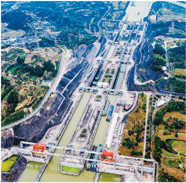
据长江三峡通航管理局数据，2021年前三季度，三峡枢纽通过量1.1亿吨，同比上涨14.37%。其中，三峡船闸通过量1.07亿吨，同比上涨11.43%。图为船舶有序通过三峡五级船闸。 郑家裕摄（新华社发）
