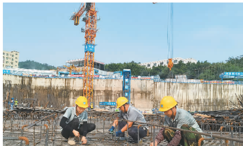
中秋节到来之际，广东省深圳市南山区羊台书苑项目施工现场的工人们依旧坚守岗位，全力保障项目建设快速推进。羊台书苑项目建筑面积约30.55万平方米，为产业、教育、居住一体化社区，建成后将优化人居环境和社区教育资源配置，进一步加速深圳科教强市建设与城市面貌更新。图为9月18日，中建二二公司的工人们在现场作业。
