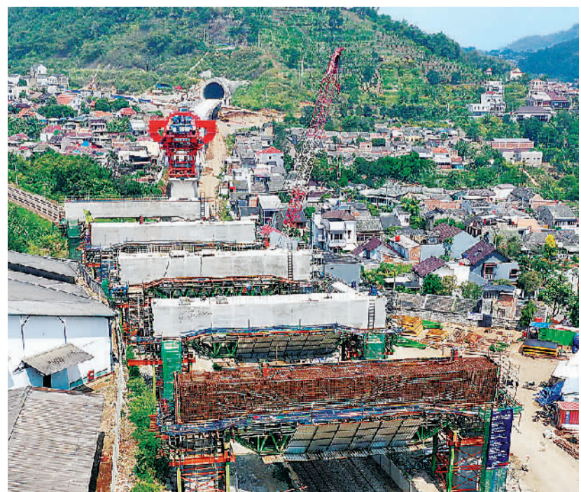
日前，雅万高铁万隆段跨既有铁路箱梁架设计划工程现场。中国中铁四局雅万高铁项目部供图。
