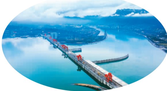
三峡水库在下游进入枯水期时，实施生态补水。图为三峡大坝。 郑坤摄(人民图片)
