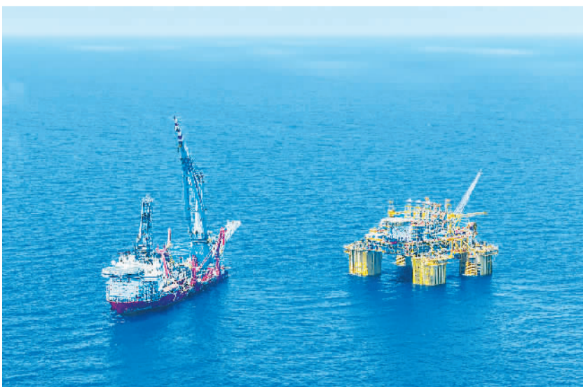
在海南陵水海域拍摄的“深海一号”大气田。新华社记者 蒲晓旭摄
