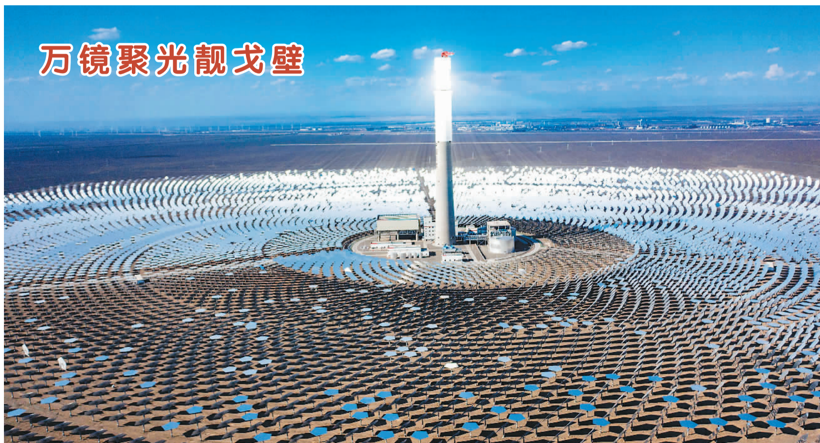
秋日时节，位于新疆伊吾县淖毛湖镇的戈壁上风日和丽，哈密50兆瓦塔式光热发电站里，1万多面定日镜“逐日”而动，将百米高的集热塔照得发亮，成为了戈壁上一道靓丽的风景。图为光热发电站外景。蔡增乐摄（人民视觉）
