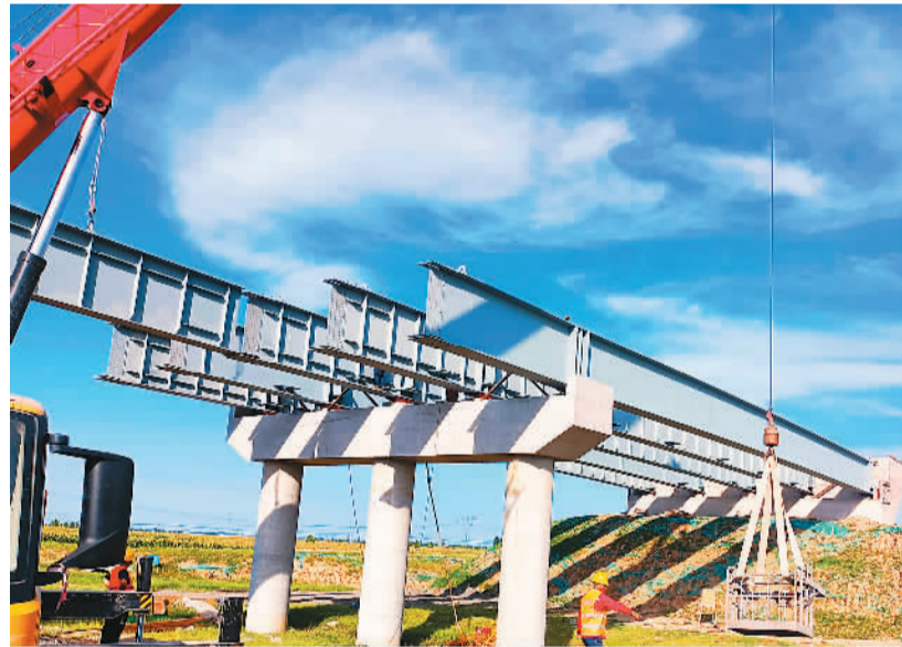
8月30日，由中建路桥集团承建的河北省邯郸市主城区大外环国道G107项目控制性工程青兰互通，首次采用工字梁结构开始上部结构施工。该结构形式具有工期短、造价低、便于施工等优势。图为施工现场。 王利玲摄
