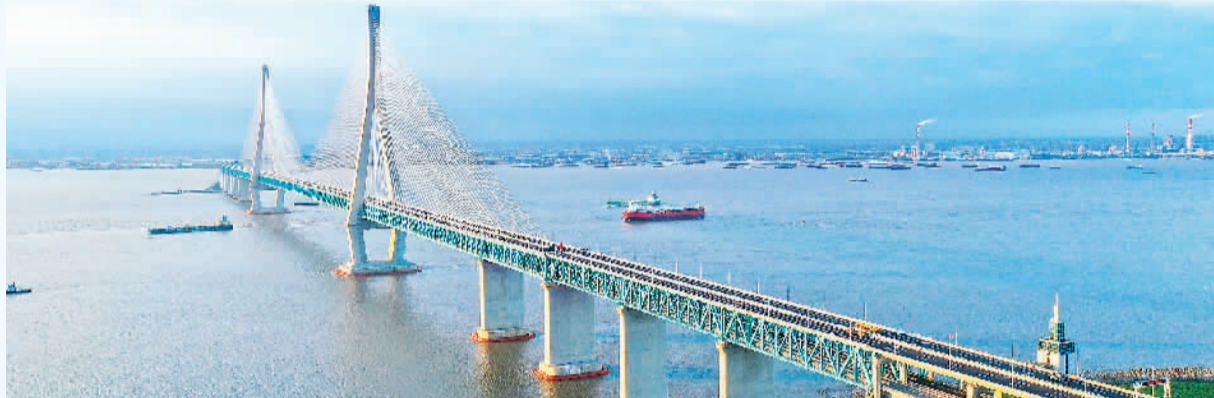
2020年7月1日通车的沪苏通长江大桥，是世界首座主跨超千米的公铁两用斜拉桥。新华社记者 季春鹏摄
