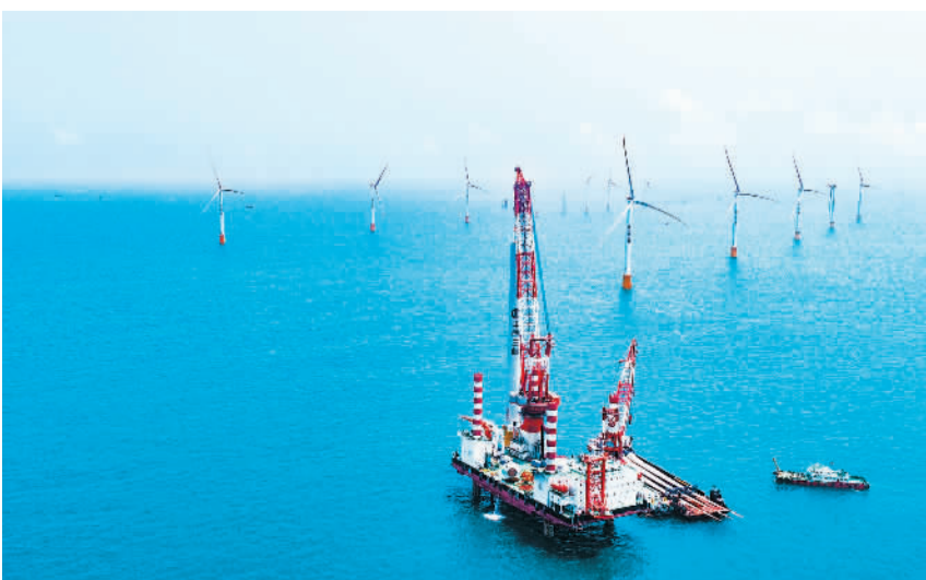
建设中的三峡新能源阳江发电公司海上风电机组。赖增鹏摄
