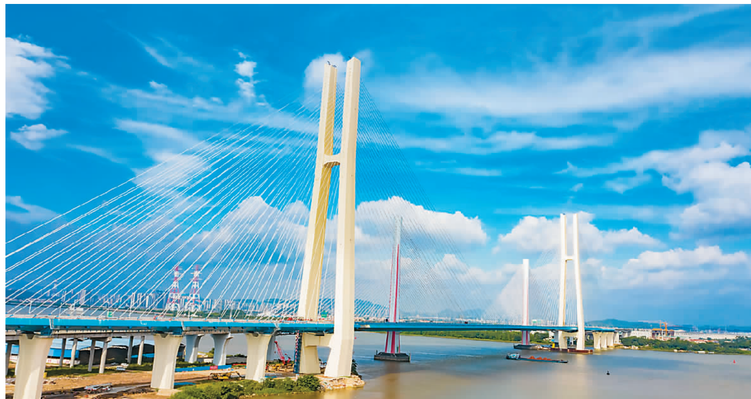
广东江西南沙港铁路跨西江斜拉桥位于广东佛山市和江门市交界处,是粤港澳大湾区基础设施“硬联通”重点工程。金伟摄(人民视觉)
