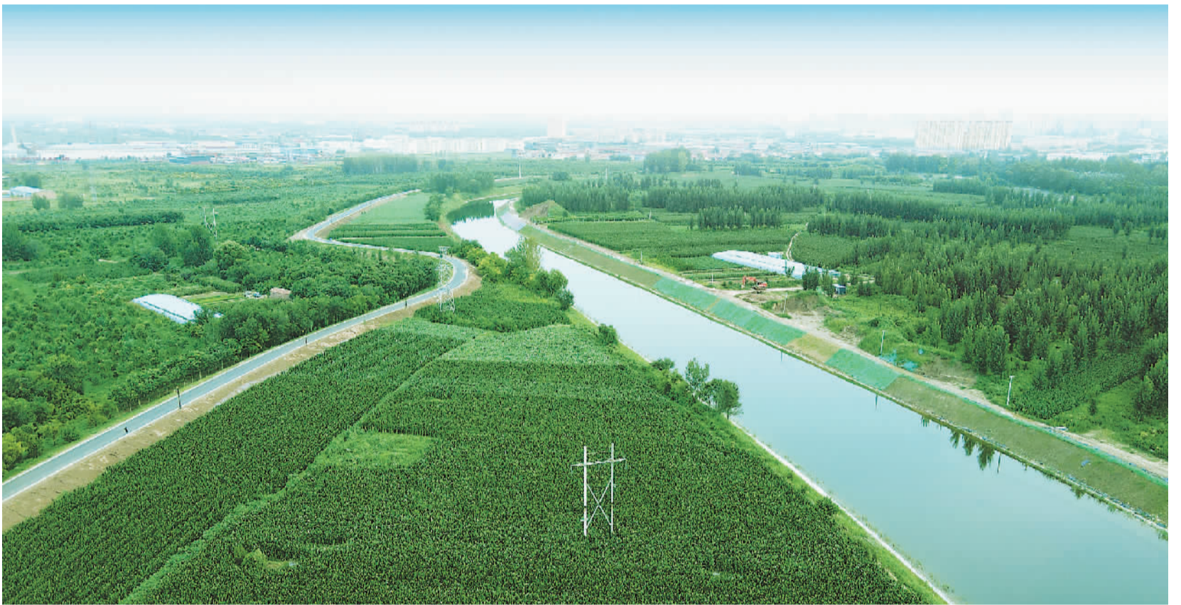
8月23日，京杭大运河沧州段堤顶路修复改造提升工程贯通。该工程由中铁二十二局集团四公司承建，全长46公里，集交通、景观、游憩、健身于一体，是“大运河国家文化公园”的重要组成部分，也是中国大运河非遗文化公园重点项目。该项目是京津冀协同发展、共同推动生态环境保护的重要举措，其生态修复与环境改善模式探索具有一定的示范意义。图为大运河沧州段和完工的大运河堤顶路景观。 孔祥文 窦曼摄（人民视觉）
