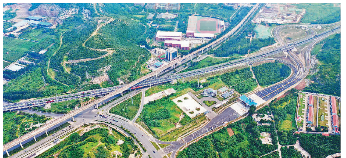
8月18日，由中建路桥集团山东分公司承建的济广高速长清大学科技园互通立交项目正式建成通车。该项目采用匝道下穿主线的A型单喇叭方案，总占地21公顷，总投资1.5亿元。项目建成后将优化长清区乃至济南市交通路网结构，推动省会城市群经济圈建设。图为济广高速长清大学科技园互通立交航拍全景。王永钢摄（人民视觉）
