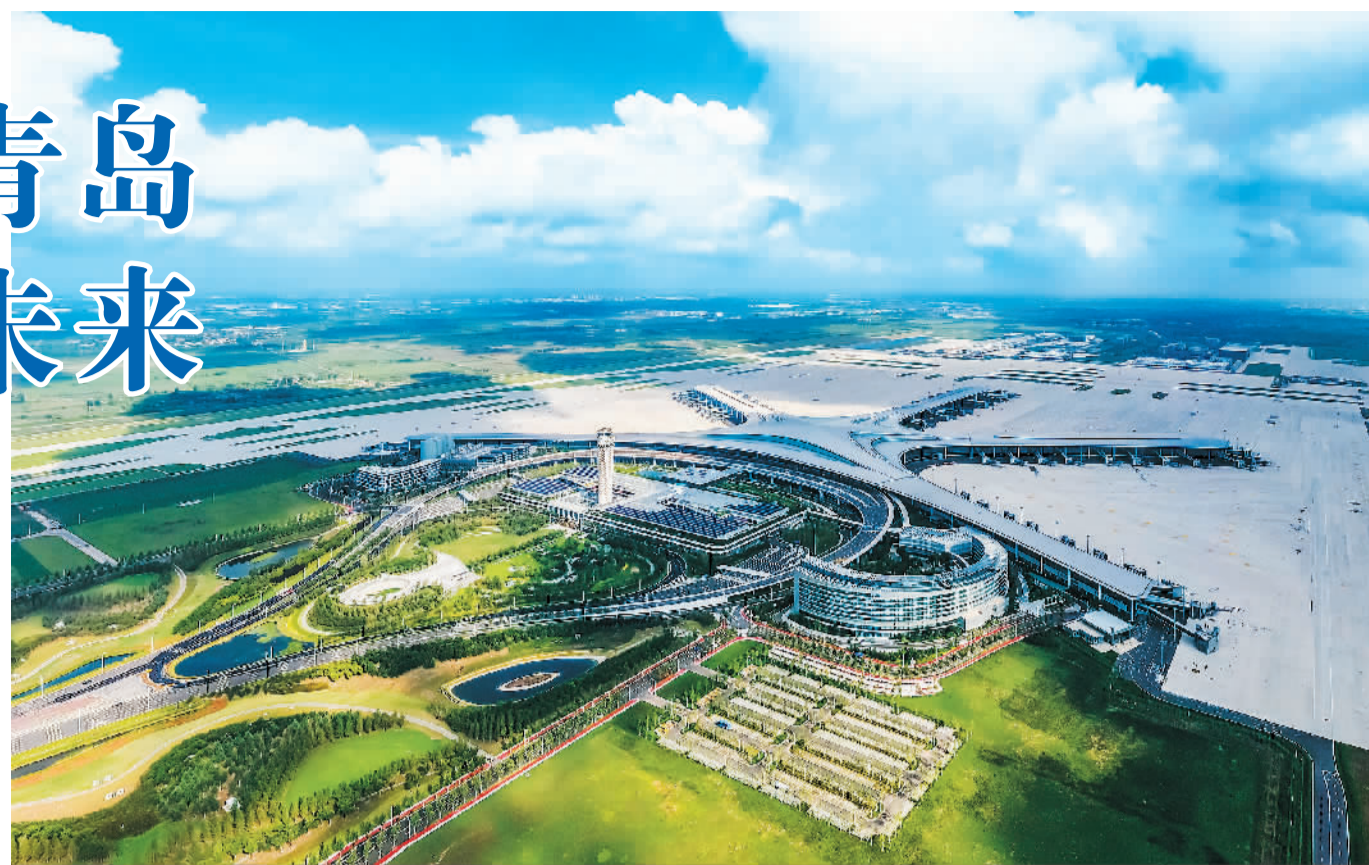
7月18日航拍的青岛胶东国际机场。
