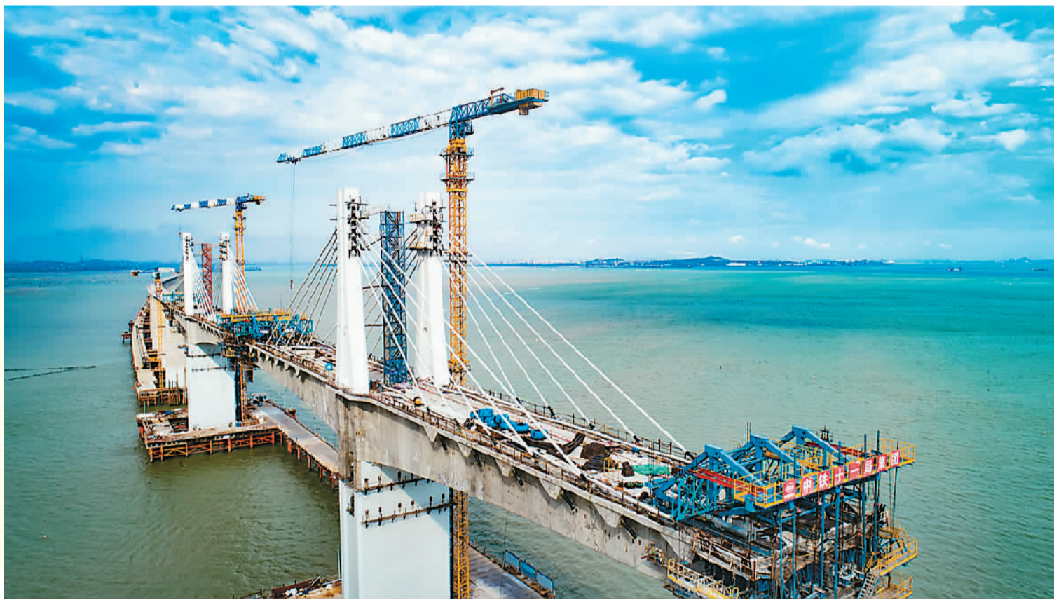
新建福厦铁路湄洲湾跨海大桥近日正在加紧施工，大桥预计10月份实现合龙。新建福厦铁路是我国首条设计时速350公里的跨海高铁，福州至厦门的铁路运行时间将由现在的2小时缩短至1小时，厦门、漳州、泉州闽南“金三角”将形成半小时交通圈，对于促进东南沿海城市群快速发展具有重要意义。
