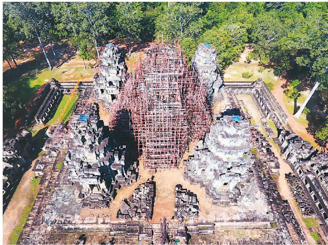
图为2017年中国承担的柬埔寨吴哥古迹茶胶寺修复项目，正在修复位于须弥台上的中央主塔。
