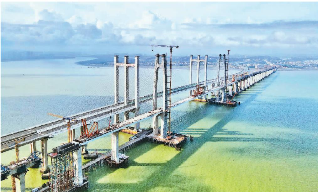
8月6日，国内首座跨海高铁桥——福厦高铁泉州湾跨海大桥主桥成功合龙，标志着福厦高铁向2022年通车目标又迈进一步。大桥全长20.29公里，有9公里跨越泉州湾中部海域，为我国首座行车时速超过300公里的跨海大跨斜拉桥。福厦高铁正线全长277公里，设计时速350公里，是福建省速度等级最高的铁路。图为福厦高铁泉州湾跨海大桥主桥。
