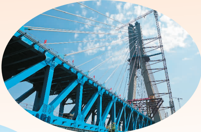
明月峡长江大桥位于长江上游重庆市南岸区广阳镇玉泉村，是国内首座双层四线铁路非对称花瓶型桥塔钢桁梁斜拉桥，上层为预留双线高速铁路，下层为重庆东环线客货共线双线铁路。图为7月26日拍摄的明月峡长江大桥合龙施工现场。
