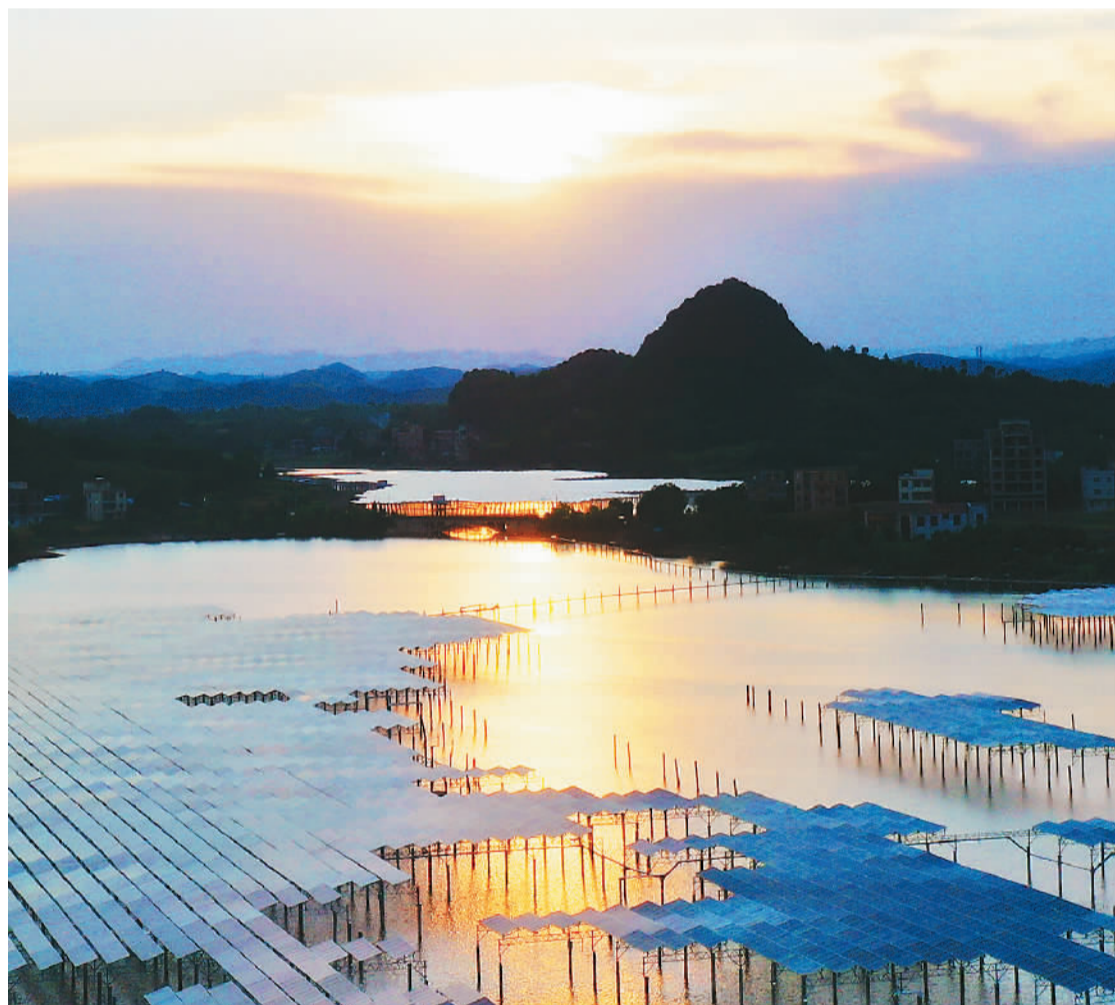
八月一日，湖南省郴州市嘉禾县千家洞水库“渔光互补”光伏发电场，光伏电板和水面在晚霞映照下交相辉映，犹如一首美丽的“渔光曲”。该项目于近期完成施工并网发电，构建了水面发电、水下养殖相结合的绿色发展模式。黄春清摄（人民视觉）
