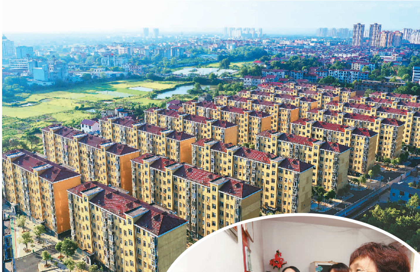
▲江西省吉安市泰和县小龙矿区国有工矿棚户区改造“龙华家园”小区俯瞰图。邓和平摄（人民视觉）
