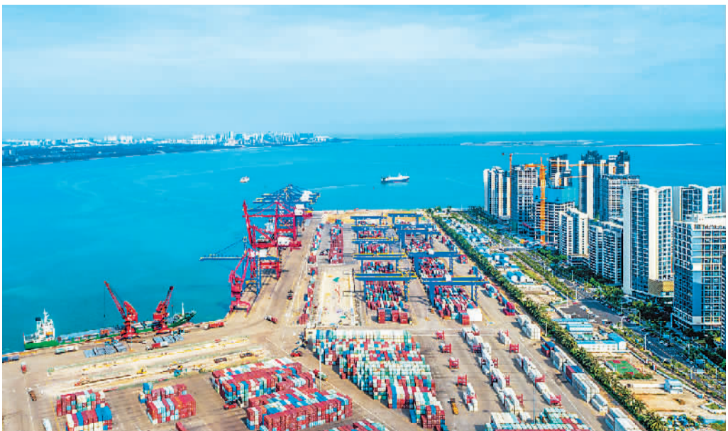
海南省海口市海口港集装箱码头智能闸口系统近日上线运行，提高了码头智能化水平和作业效率。智能闸口系统上线以来，车牌识别率达99.59%，挂车牌识别率达99.44%，平均每辆车通过时间为13.69秒。图为海口港集装箱码头的繁忙景象。石中华摄（人民视觉）
