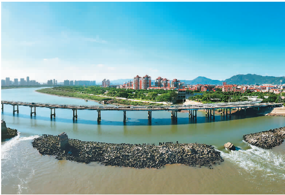
泉州顺济桥遗址。
