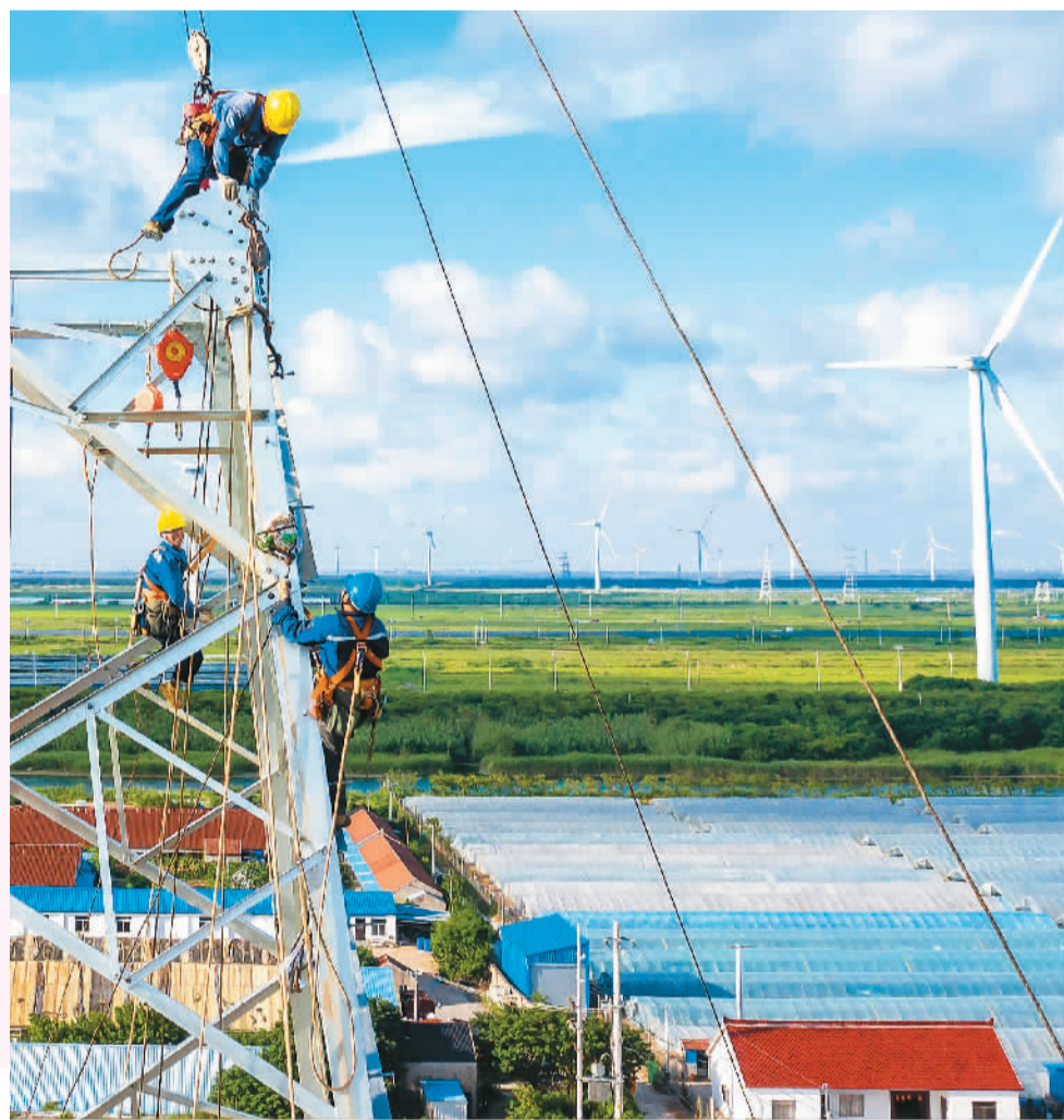
江苏南通500千伏通海输电工程作为江苏省海上风电的重要组成部分，建成后可大幅提高沿海清洁能源在全省范围内的消纳能力，助力江苏省电源结构不断优化。图为7月22日，江苏省送变电有限公司高空施工人员冒着高温组立铁塔。
