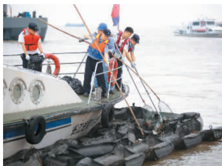
长江江苏镇江江段，机械在拆除裸露浅滩的网具。
