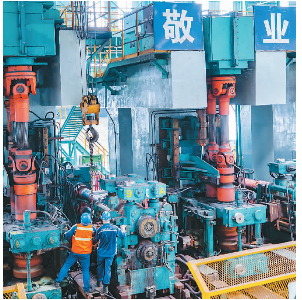
近日，中国宝武马钢股份特钢公司生产一线的工人们冒着高温维护设备。
