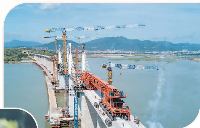
▲7月11日，中国自主研发的“昆仑号”千吨级运架一体机在中铁十一局承建的新建福厦铁路湄洲湾跨海大桥建设现场，圆满完成最后一孔40米高铁箱梁架梁任务。
