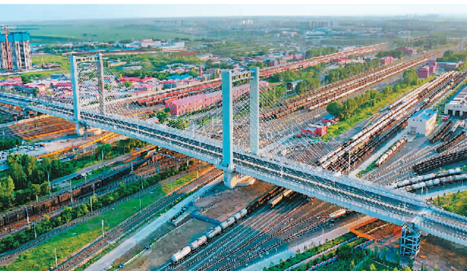
本报北京7月6日电(记者聂传清)记者从中国铁路股份有限公司获悉,由中铁二十二局集团一公司施工的国内跨越铁路既有线路最多的转体斜拉桥——哈尔滨市哈西大桥近日完工。哈尔滨市哈西大桥长843米、宽30米,为混凝土现浇连续梁结构。大桥主跨198米,两座主塔高73.7米。大桥上跨哈尔滨南站的48条铁路既有线和1条市政主干道。
