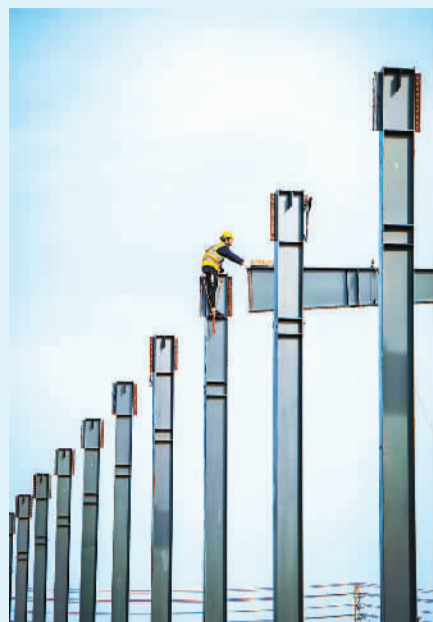
在江苏省宿迁市苏宿工业园区的峰电器智慧家电项目工地上，工人们正在安装钢结构厂房顶梁。
