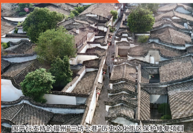
国开行支持的福州“三坊七巷”历史文化街区保护修复项目
