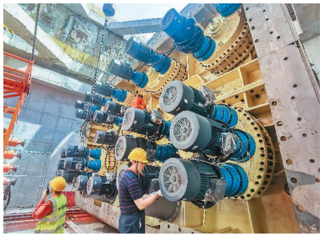
6月18日,“大运河号”超大断面矩形顶管始发仪式在中铁上海工程局苏州胥涛路对接横山路隧道工程项目举办。这意味着苏州市首条京杭大运河下穿通道,也是采用大断面、长距离矩形顶管下穿京杭大运河的城市干道——苏州胥涛路对接横山路隧道工程顺利始发。该工程建成后,将串联姑苏区与高新区,缓解两区之间跨京杭大运河的交通压力,方便大运河两岸人民出行。图为工作人员进行顶管机驱动安装。宋美璐 李升阳摄(人民视觉)
