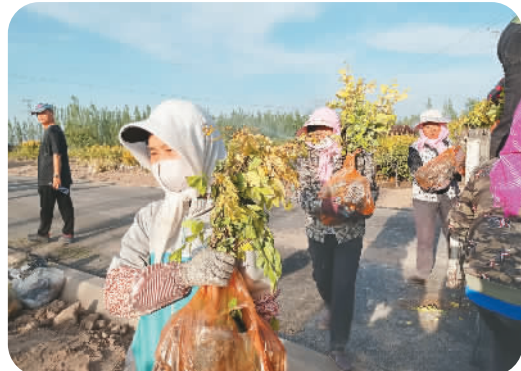
甘肃省张掖市甘州区一景点处，工人正在栽植花草绿植。成学磊摄（人民日报）
