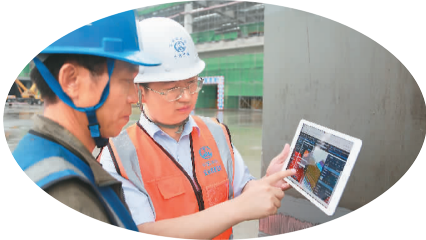
6月9日，北京丰台站项目建设现场，技术人员正指导焊接工人使用钢结构全生命周期管理平台。 中铁建工集团供图
