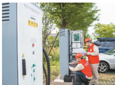
在江苏省海安市曲塘镇一国内充电桩，技术人员对新装的充电桩进行调试。翟慧勇摄(人民图片)
