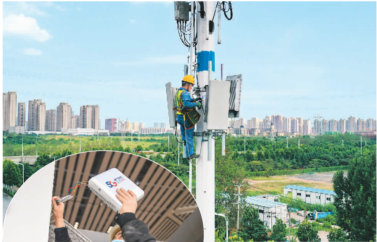
▲在安徽省合肥市蜀山区大别山路与鸡鸣山路交口附近，塔工在铁塔高处安装5G信号设备。 陈三虎摄（人民图片）
