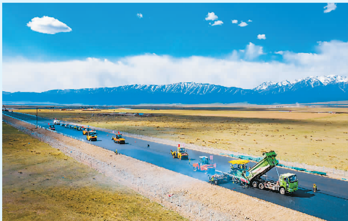
5月20日，G7京新高速公路与G575线新疆哈密至巴里坤段项目交界处正在铺设沥青。普拉提·尼亚孜摄（人民视觉）
