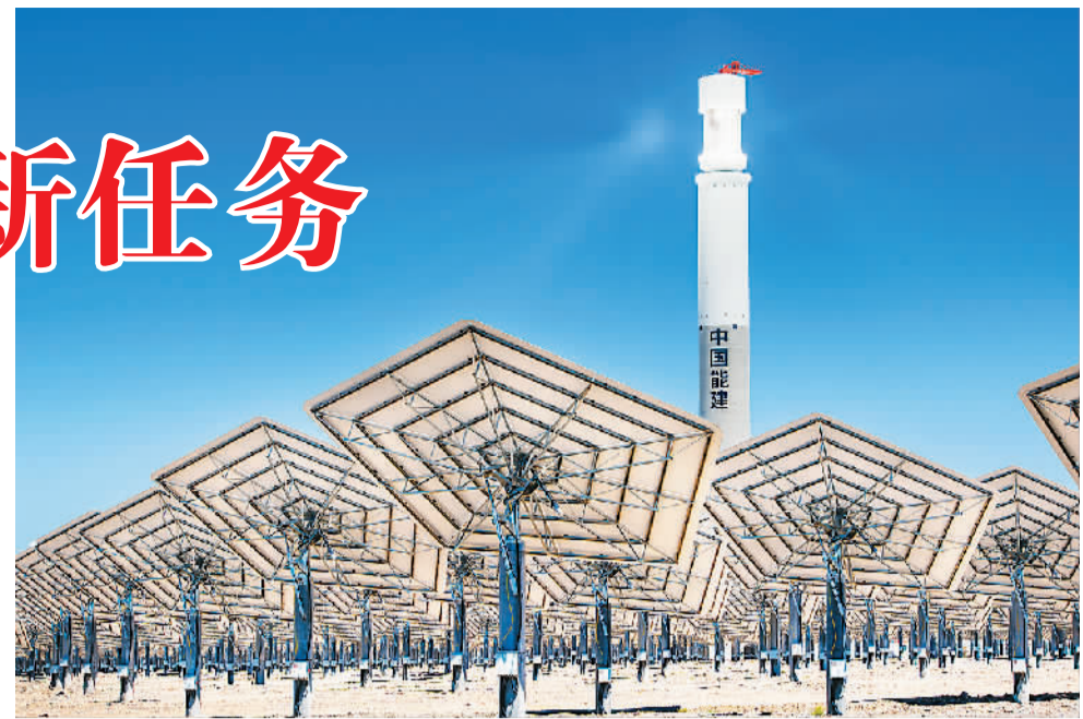
图为5月23日,在新疆哈密市伊吾县淖毛湖镇戈壁上的光热工业园区内,中国能建投资公司投资建设的哈密50兆瓦熔盐塔式光热发电站进行调试定镜工作。哈密光热项目建成后,预计每年可提供1.98亿千瓦时的清洁电力。李华摄(人民视觉)
