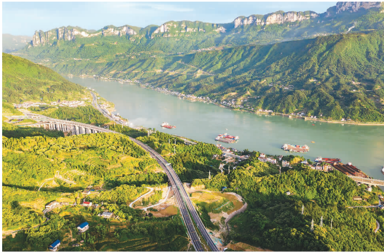
5月20日,三峡翻坝江北高速公路顺利通过竣工验收,将于7月1日正式通车。该高速公路起于湖北省宜昌市夷陵区太平溪镇,终点与宜巴高速相接,是三峡翻坝转运体系的重要组成部分。图为5月24日拍摄的三峡翻坝江北高速公路。 郑家裕摄(人民视觉)
