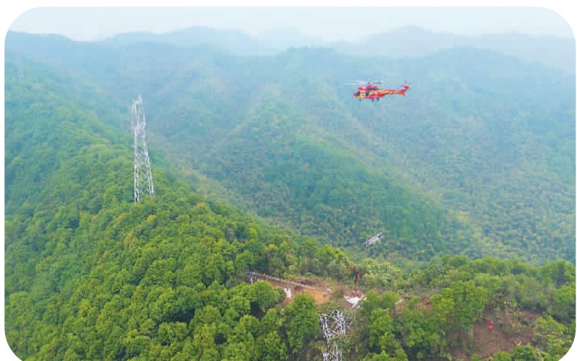
日前,浙江省绍兴市局部地区出现极端强对流天气,造成兰风线6基铁塔受损,国网浙江电力公司引入直升机参与抢险,这也是国内电力领域首次采用直升机进行抢险作业。 王浩摄
