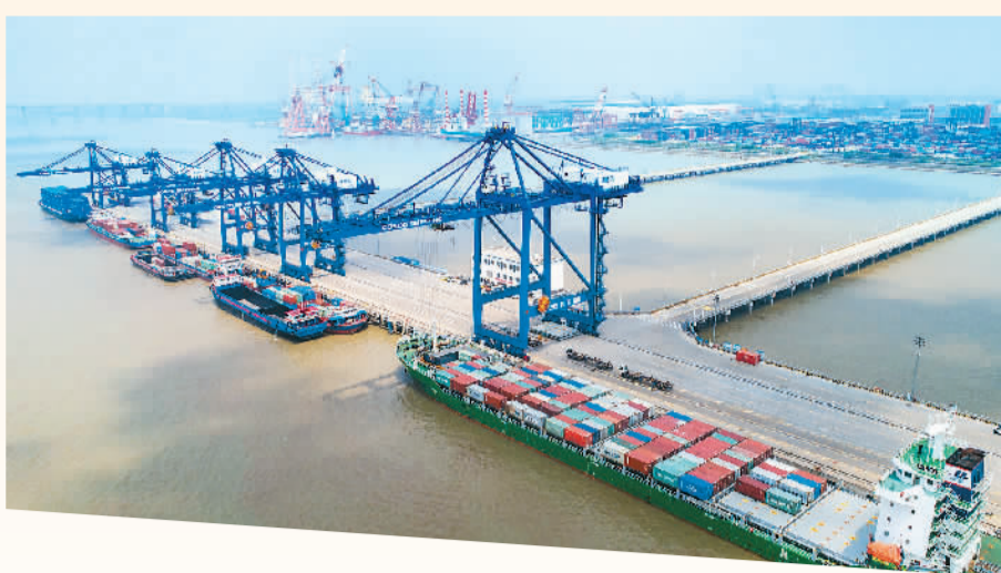
5月17日,江苏南通通州区集装箱码头,大型机械正在吊装货物。翟慧勇摄(人民图片)
