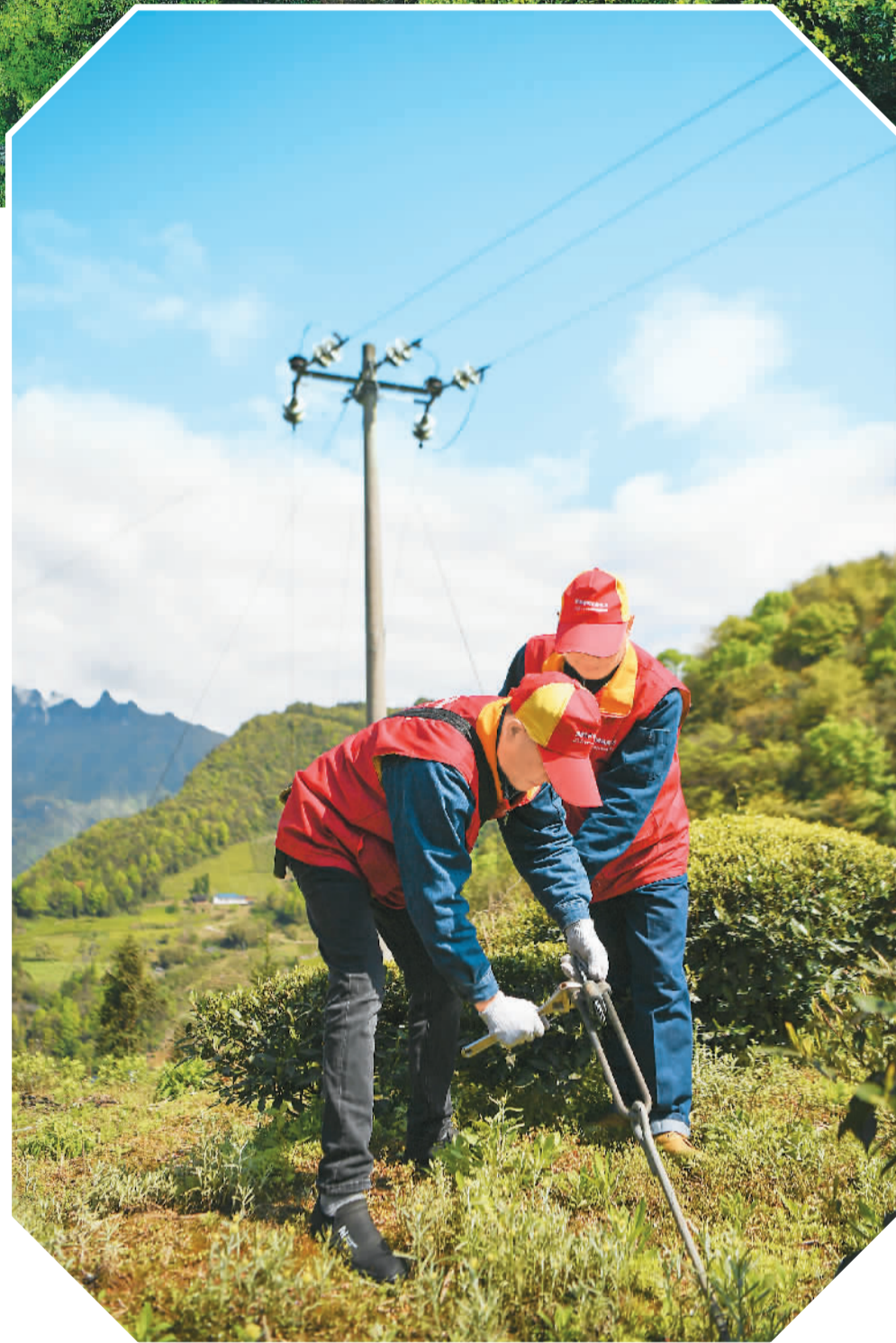
▲ 壶瓶山供电所的工人在壶瓶山镇管山村巡线。
