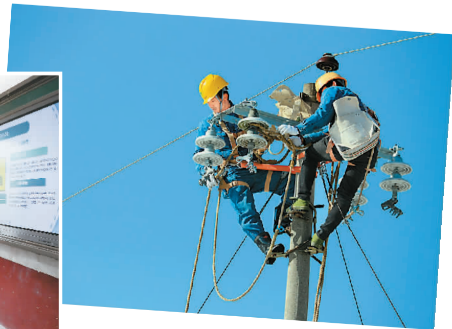
▲ 壶瓶山供电所工人周长勇（左）、谭功波在石门县南北镇白竹山村开展电网改造施工。资料照片
