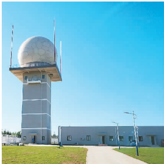
北京大兴国际机场的C波段全数字有源相控阵天气雷达。 百度图片
