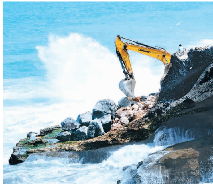
柳工CLG950挖掘子在摩洛哥的大西洋沿岸作业。
