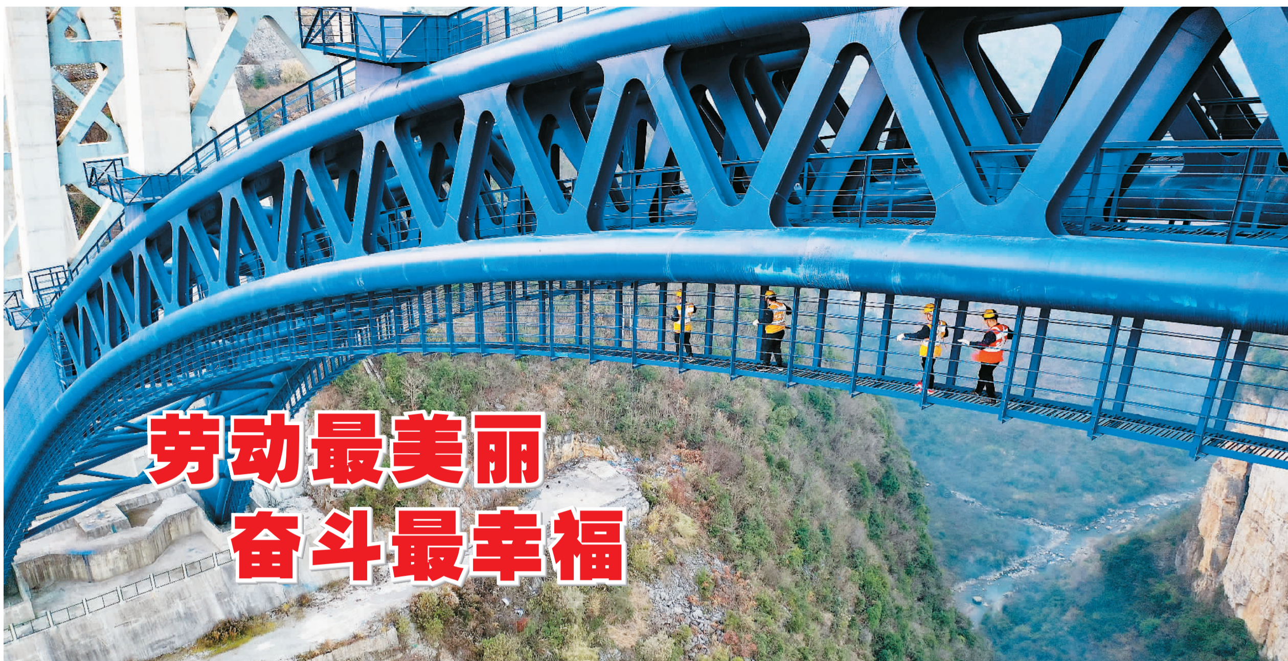
▲ 在成贵高铁西溪河大桥，贵阳高铁工务段毕节桥路车间工人，在250多米的高空中对大桥进行体检，确保行车安全。 新华社记者 刘 续 摄
