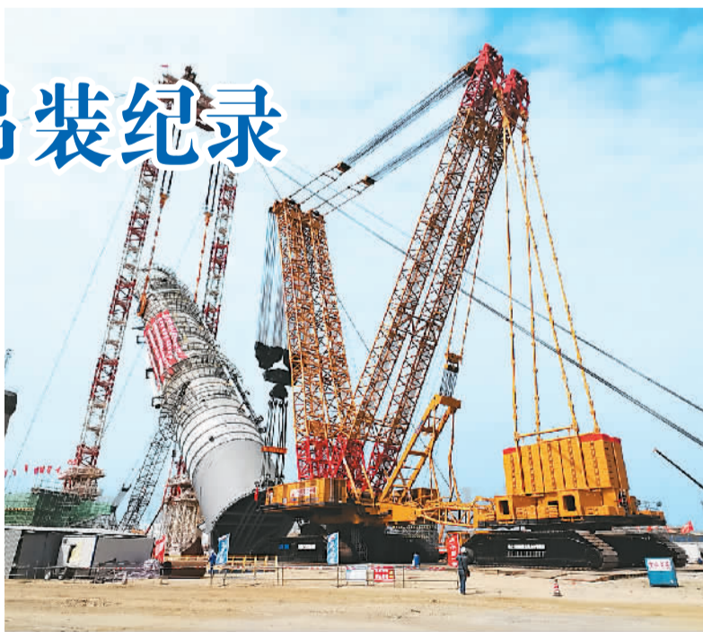
正在进行吊装的抽余液塔。
