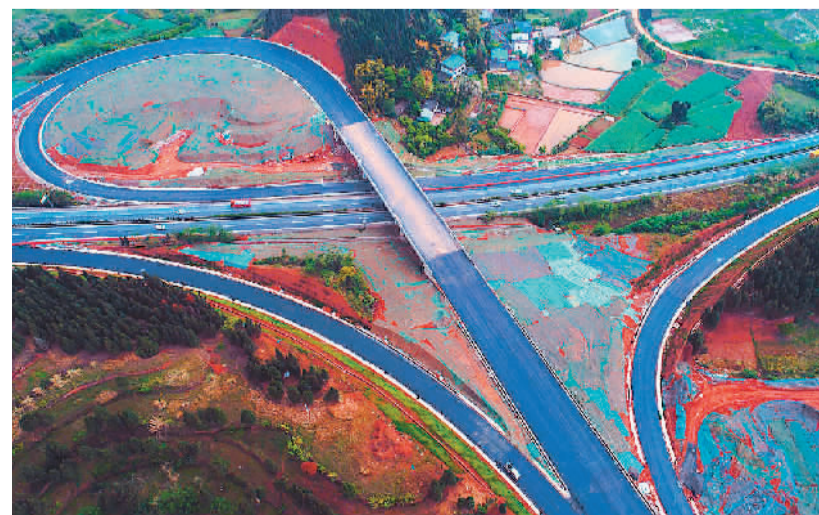
日前，由中建路桥集团承建的四川绵阳至遂宁高速公路龙凤互通立交桥梁主体工程完工。绵遂高速是成渝环线高速的重要组成部分，也是四川南向出川（至重庆、广东）大通道的重要路段。 颜 雄摄
