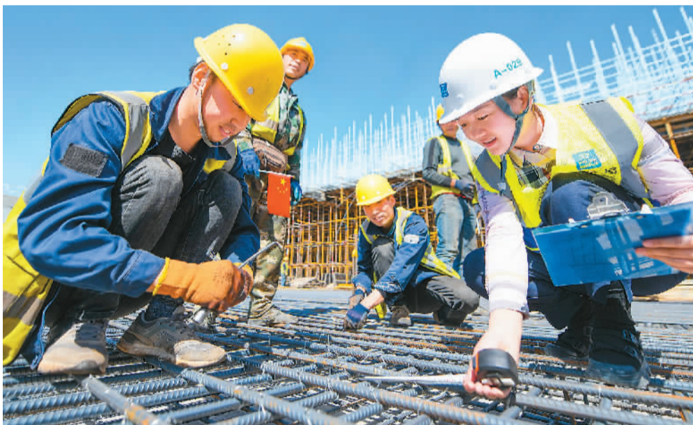
4月16日，一场劳动技能竞赛在新疆乌鲁木齐机场改扩建工程现场举行，参赛工人大显身手比拼技能，比赛现场热火朝天。劳动竞赛涉及安全生产、工程质量、工程进度等建设项目重点工作。图为来自中建三局的施工人员参加钢筋绑扎比赛。新华社记者 王菲摄
