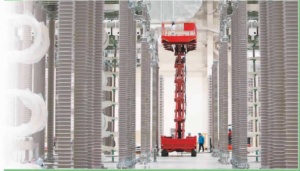
▲在张北柔直换流站阀厅内，施工人员正在安装阀塔模块。 邹明摄
