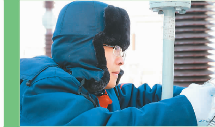
▲国网冀北检修公司职工李振动在500千伏北京环网变电站停电检修现场。 刘洁摄
