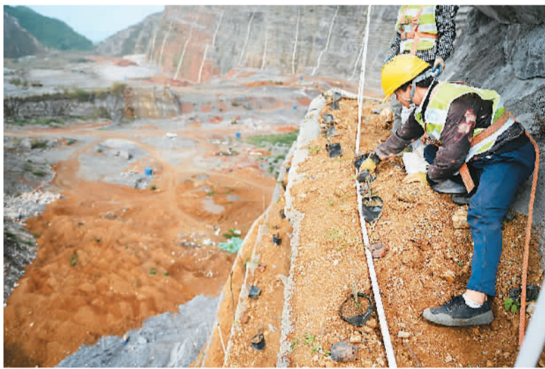
▲ 工人在作业平台上整理泥土、摆放树苗。
