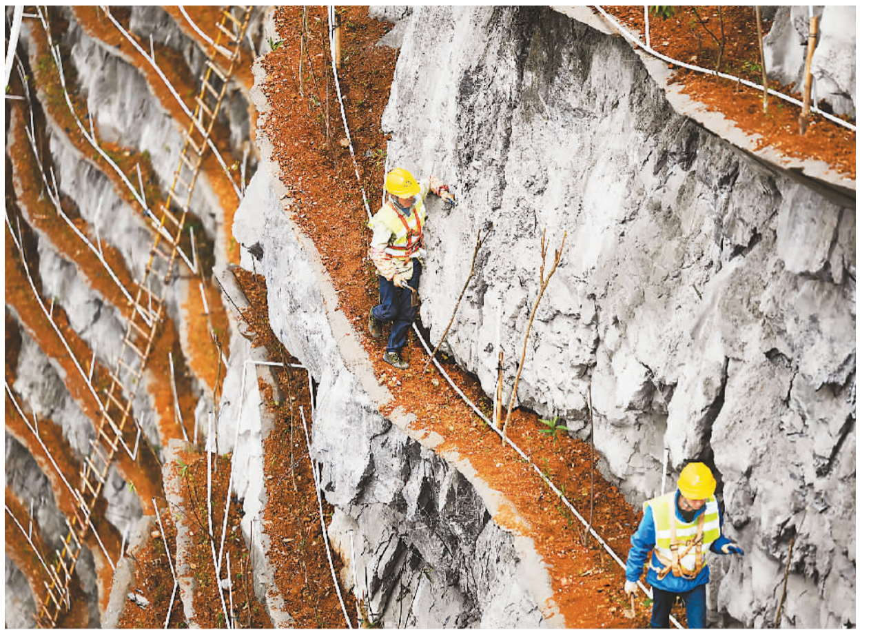
◀ 在楼梯山体复绿现场，工友们沿着山体行进。
