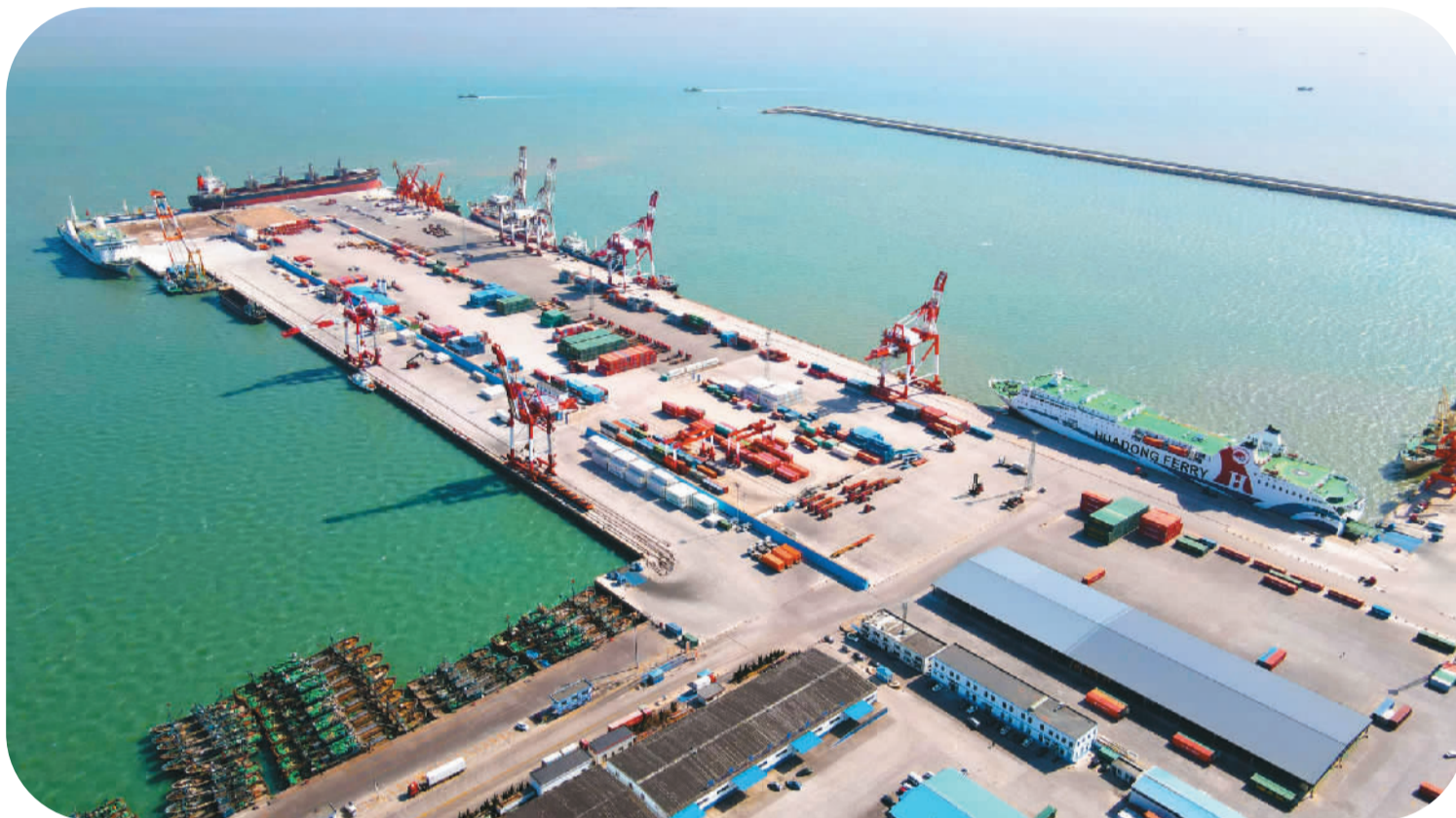
3月16日，山东省荣成市石岛管理区石岛新港港口，一艘大型客滚轮正在卸货。
